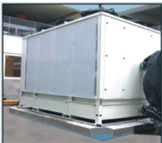
氣動輸送設備安裝隔離墊材
