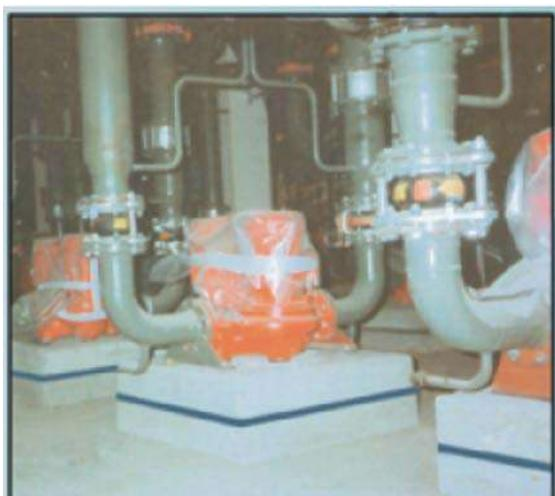
泵浦設備安裝隔離墊材
